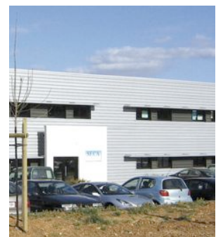
Le bâtiment situé rue des Entreprises à Migné-Auxances, dont SECA est le locataire satisfait.
